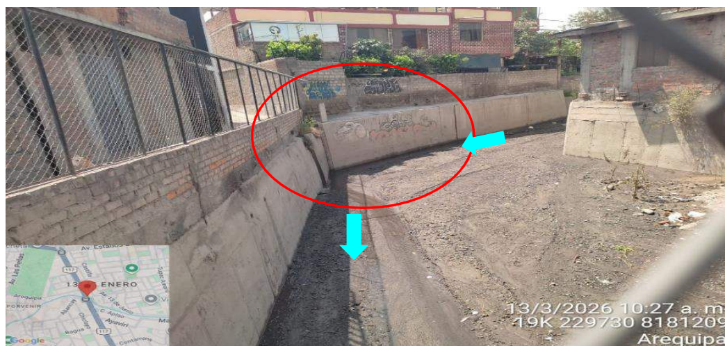
FIGURA N°01: TRAMO CRÍTICO EN LA QUEBRADA S/N, SE OBSERVA LA CURVA DONDE EL AGUA PUEDE INUNDAR, SE REQUIERE DESCOLMATACIÓN DE CAUCE LAS VIVIENDAS TRAMO SIN DELIMITACION DE FAJA MARGINAL EXPUESTO A PELIGROS POR INUNDACION
